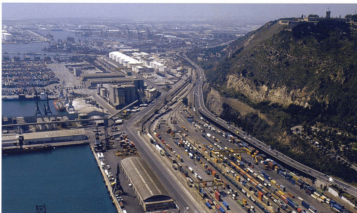
Moll de la Costa del Port de Barcelona. Port de Barcelona
