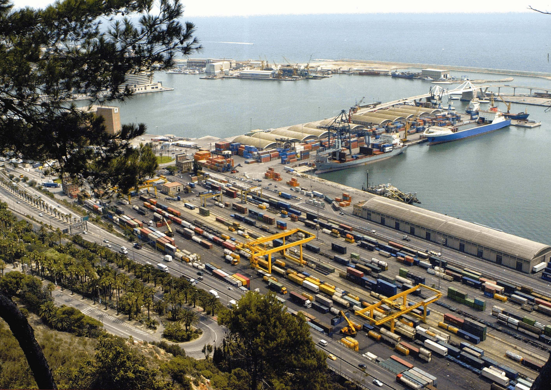
Vista de la terminal ferroviària del Port de Barcelona. R. Vilalta
