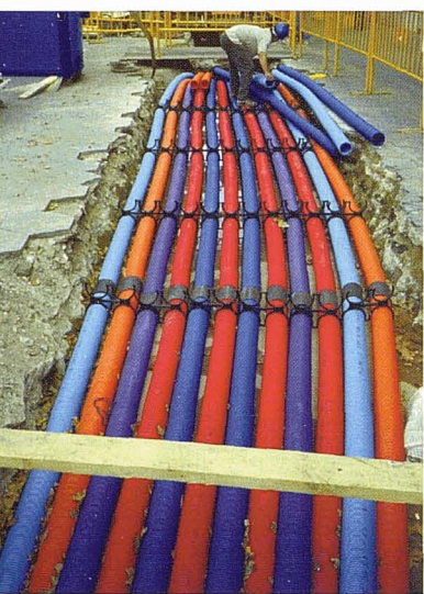
Instal·lació de cables. R. Moreno
