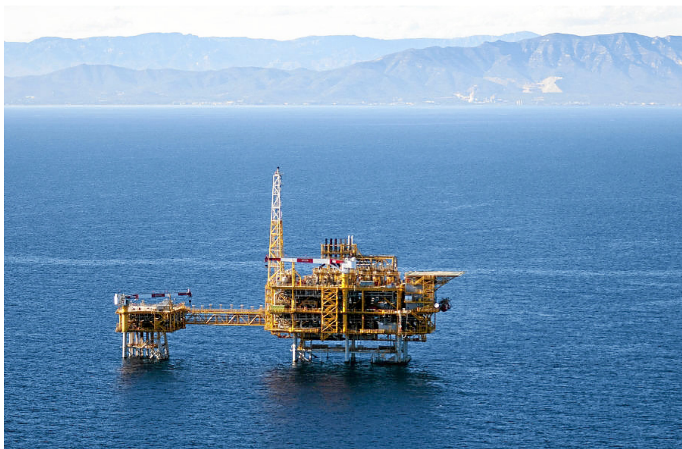
Fig. 1: Vista aérea, mirando hacia el noroeste, de las plataformas del Proyecto Castor (cortesía de Tjerk van der Meulen). Están situadas a 21 km de la costa y construidas sobre el fondo marino, a 60 m de profundidad. La mayor alberga instalaciones de procesos, y la menor es de donde parten los sondeos. Las sierras montañosas al fondo, paralelas a la costa, muestran la impronta estructural de fallas normales con esa dirección. Las principales fallas submarinas conocidas en el entorno tienen una dirección similar.
