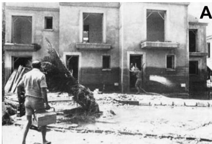
Fig. 3. A. Urbanización Costa Laguna durante su construcción inundada por la crecida de 7 de septiembre de 1989, con un nivel superior al metro y medio por encima del nivel de calle, tal y como se observa en la marca de barro en la fachada de los edificios (Foto de J.J. Mullor). B. Casas de la misma urbanización afectadas por la crecida de 2012. El nivel de la crecida (superior a 2 m) queda marcada por los flotantes adheridos a la fachada. (Video en http://www.youtube.com/watch?v=460q_cxmS4U ).
