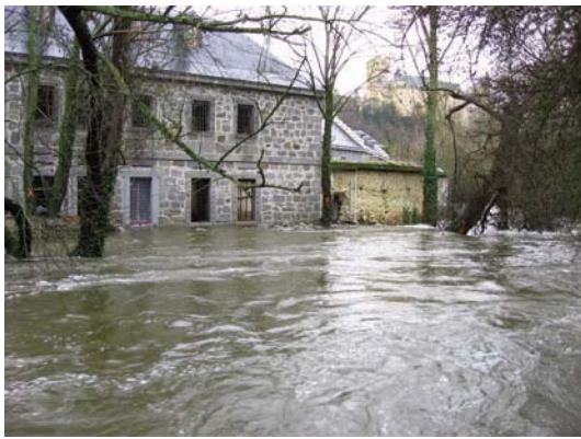
Fig. 3. Vista parcial de la inundación producida por el desbordamiento del río Eresma (Cuenca del Duero) a su paso por las inmediaciones de la Ciudad de Segovia (Alcázar al fondo), anegando los sótanos de la Casa de la Moneda. Dicha "ceca" es considerada la fábrica mecanizada de moneda más antigua del mundo que todavía sigue en pie. 29 de enero de 2009. Foto: Mariano Otero (Unidad de Protección Civil de Segovia).
