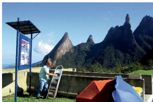
Figura 11. El mantenimiento periódico de los paneles hecho por la equipo del DRM-RJ.
