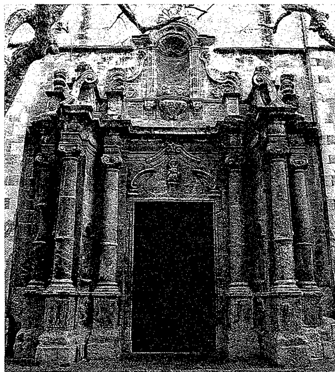
Vista general de la portalada. Les coloracions de la superfície dels paraments ens indiquen la presència de crostes i recobriments de diferent naturalesa, que, a part de dificultar el gaudi estètic i la lectura del monument, en determinats casos ens alerten de problemes d'alteració dels materials de pedra (Pau Arroyo, 12/2/94).
