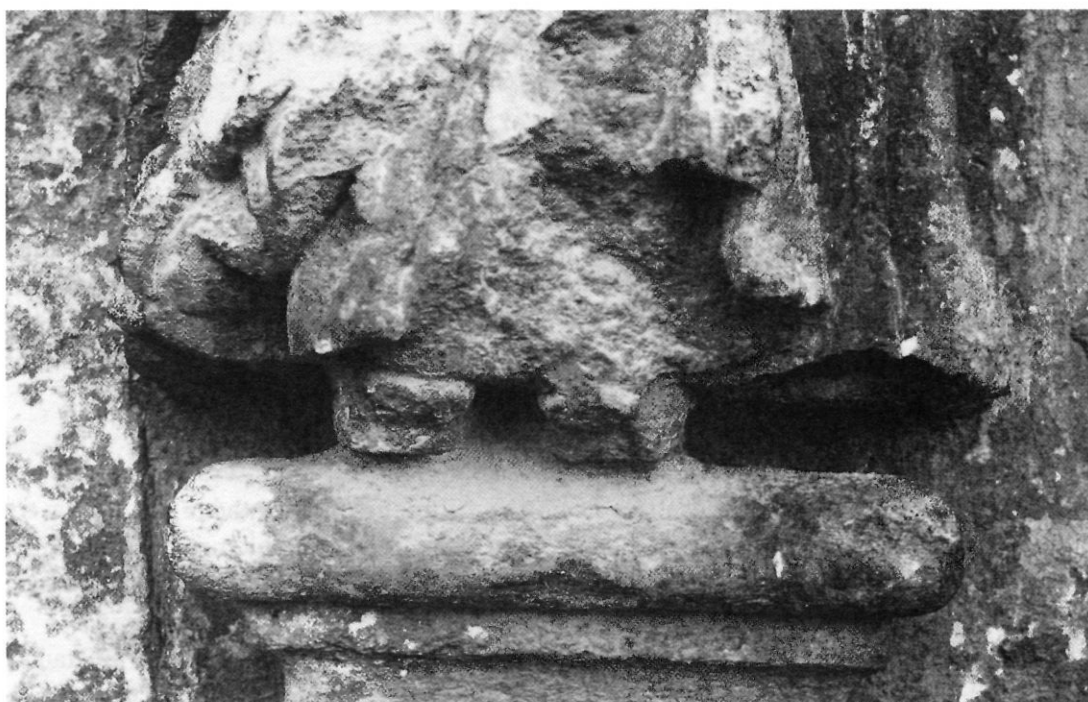
Detall de la part inferior de santa Anna. S'aprecien perfectament les grans acumulacions de crostes de brutícia. Hi destaca la que es coneix amb el nom de "crosta negra", els components de la qual, bàsicament cristalls de guix, faciliten l'ateració de la pedra amb la qual estan en contacte amb la presència d'aigua (Pau Arroyo, 26/2/98).
