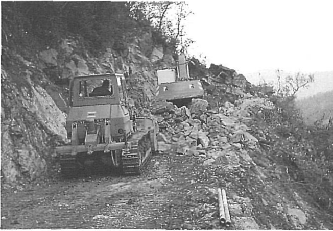
Procés d'obertura de la pista. Subtram 2.1: Pont de Bolacell-Cordonet (març de 1992).
