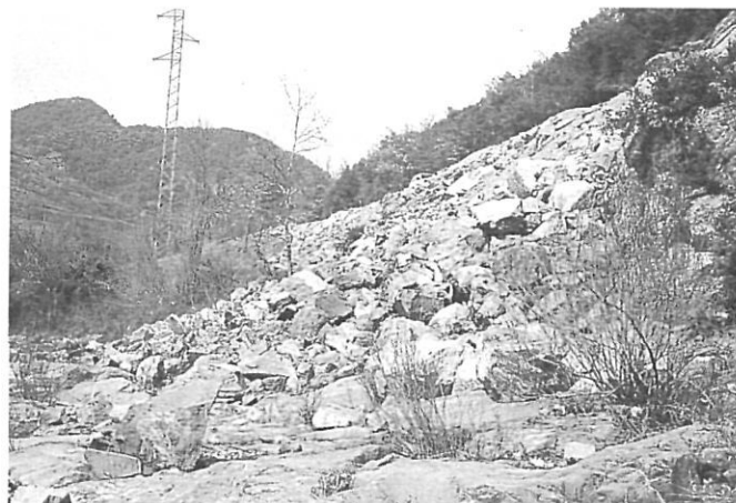
Abocament de blocs de roca a la riera de Beget, prop del molí d'en Quelet. En el primer tram construït: Beget-Pont de Bolacell (març de 1992)
