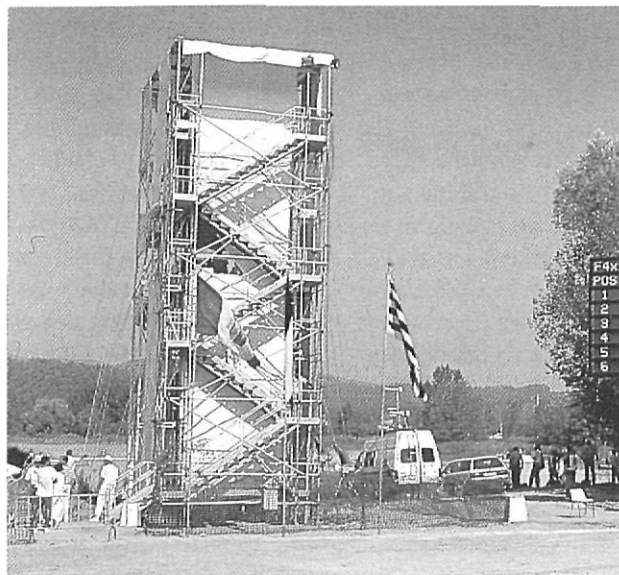
A la zona d'arribada s'hi instal·la la torre de control i d'àrbitres
