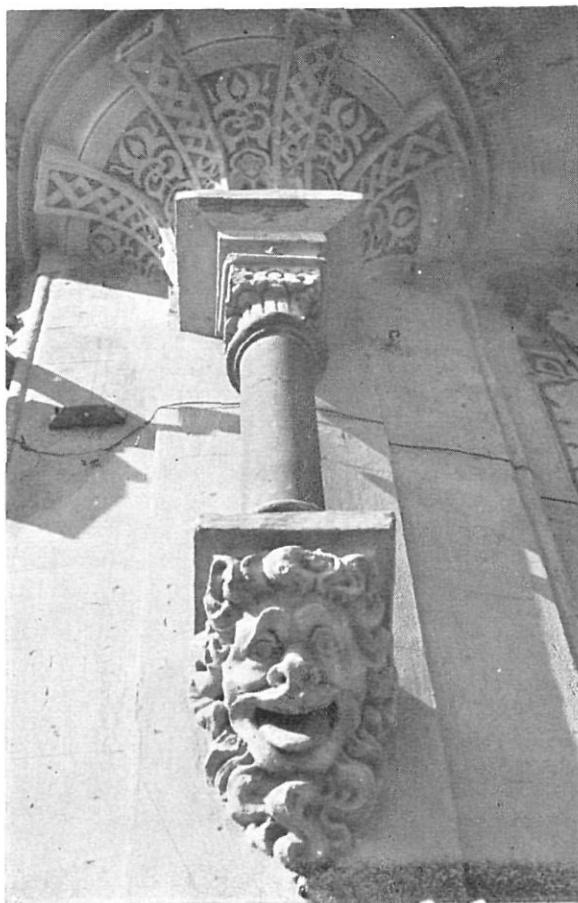
Columna amb peanya que aguanta la torre d'angle (Foto Alexandre Matas).
