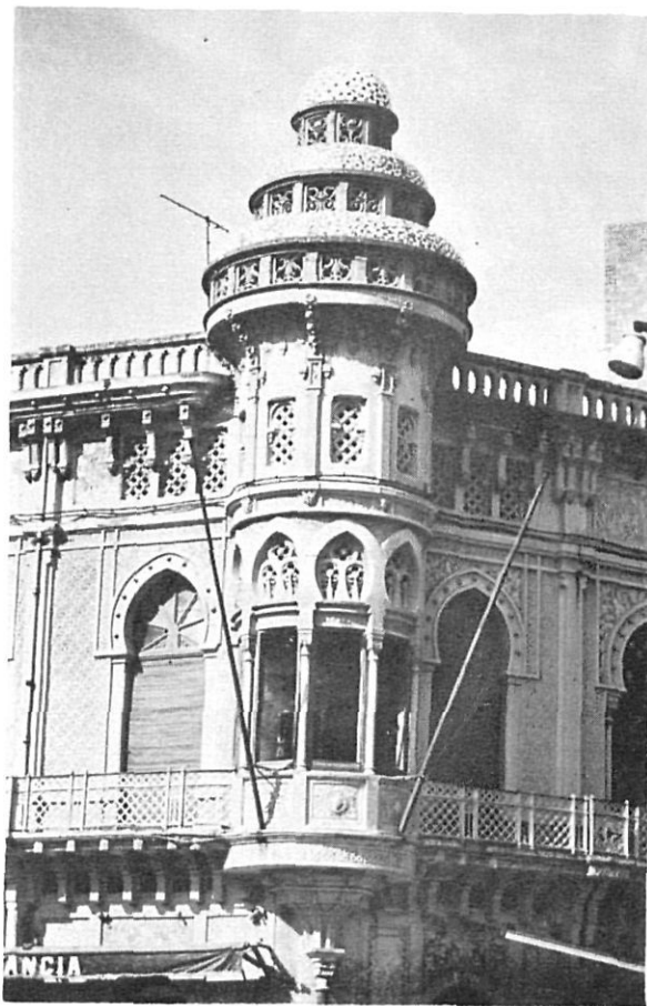
La torre-mirador actual; el cos superior de la cúpula és modificat. (Foto d'A. Matas).
