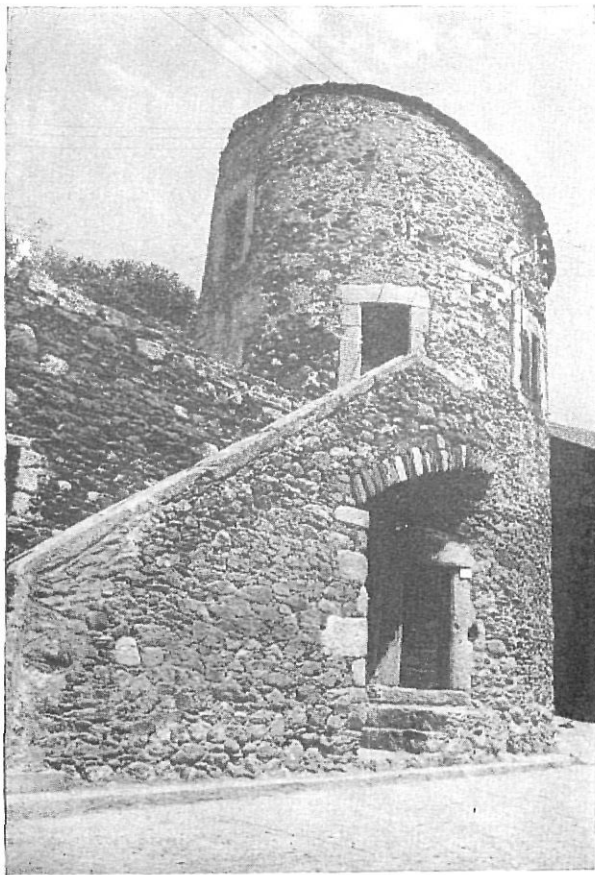
Aspecto exterior de la torre de las fortificaciones de Llívia donde se halla instalado, en forma de Museo, el material de la Farmacia
