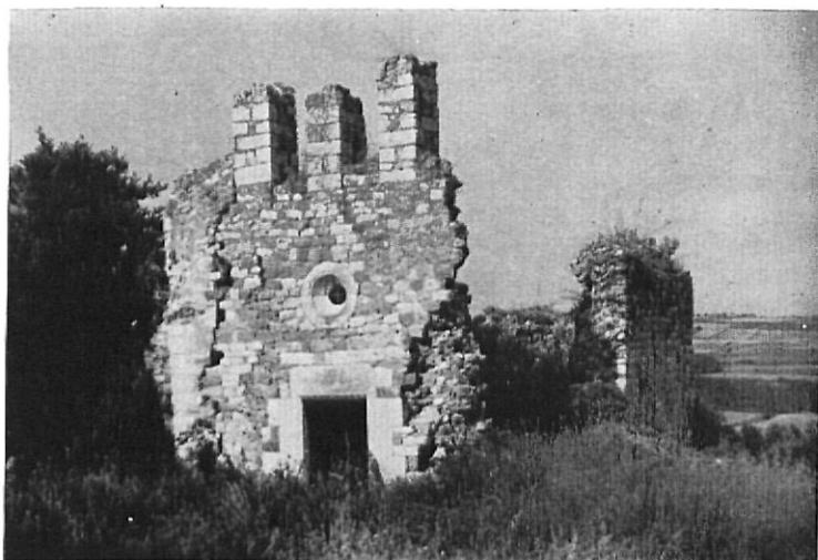
*Fig. 17.—Conjunto de la iglesia de San Joaquín en la que se aprecia claramente el derrumbe de la pared lateral y la ruina que amenaza a la construcción.*
