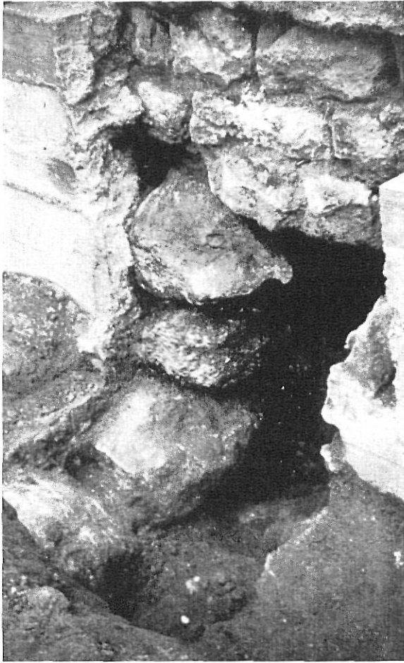
Fig. 4. — Aspecto del muro de estructura ciclópea
