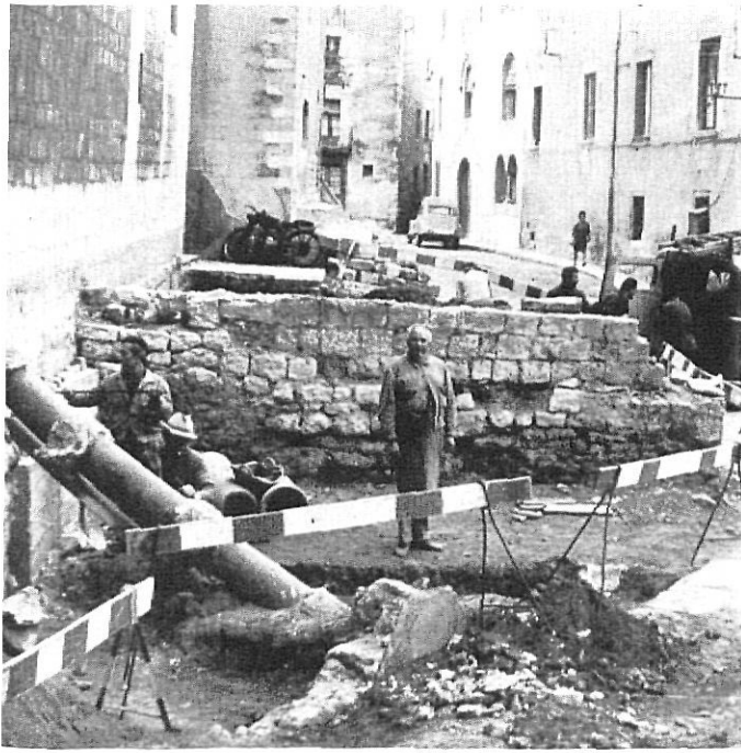
Fig. 8. — Muro medieval con doble estructura
