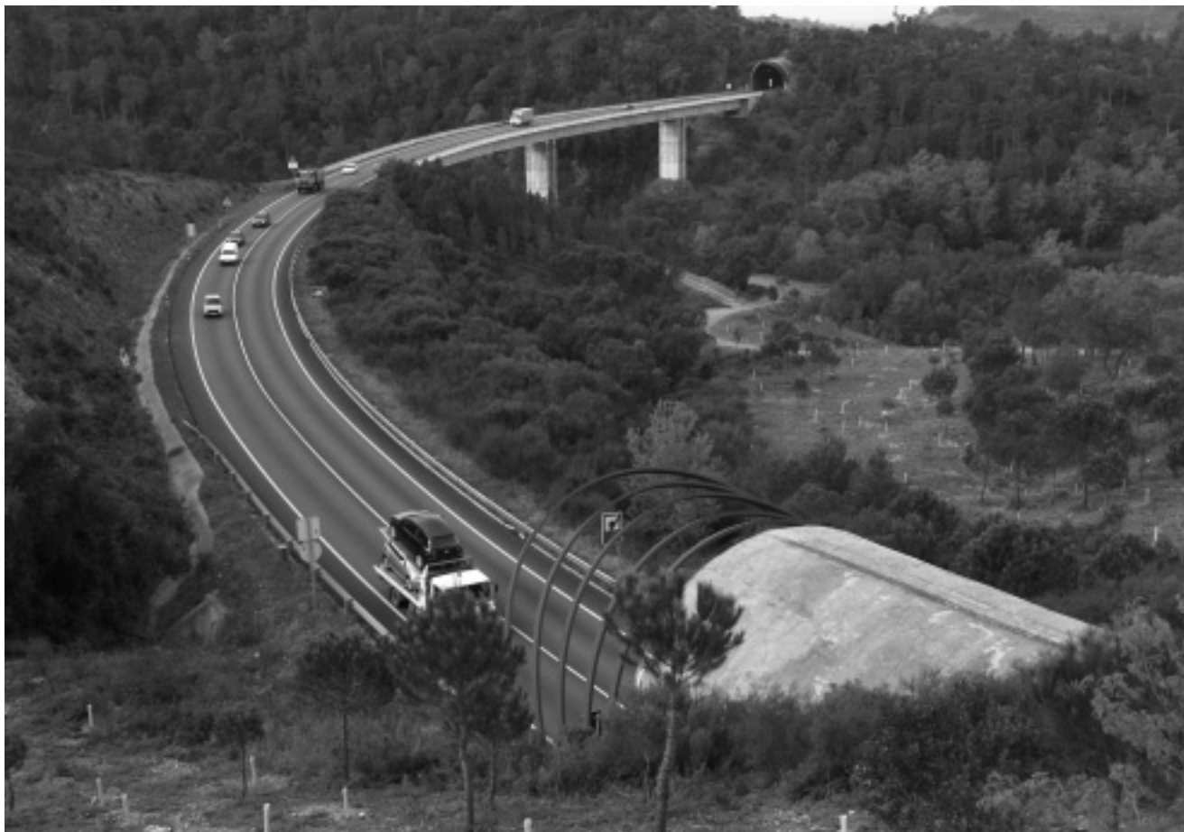
La successió de falsos túnels i viaductes a la variant de Girona evita el seu efecte barrera.
