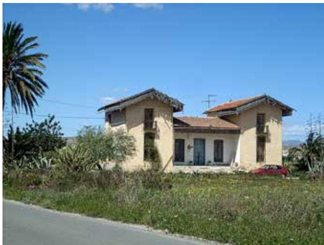
Figura 6. Casa de camp amb dos cosos bessons, març 2013.
