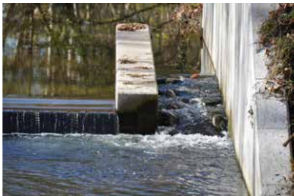
Figura 5. Rampa per a peixos de l'estació d'aforament EA013 de l'Agència Catalana de l'Aigua al riu Fluvià a Olot (la Garrotxa). Any 2013. Autor: Marc Ordeix.
