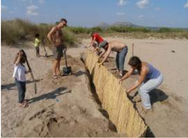
Instal·lació de pantalles per facilitar la restauració de les dunes
