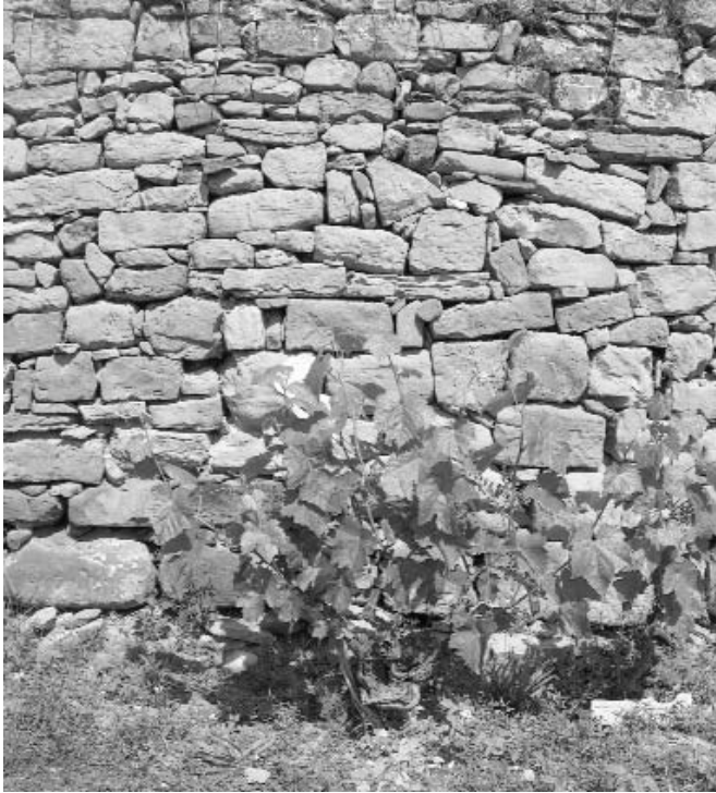
Marge de pedra seca amb presència de vinya (Sant Fruitós de Bages)
