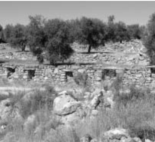
Relleu marcat per bancals d'oliveres que s'adapten als desnivells orogràfics mitjançant els marges construïts amb pedra seca. El marge inferior conté 5 arneres integrades al conjunt de l'espona. Fotografia: Mateu Esquerda (5 de setembre de 2006).
