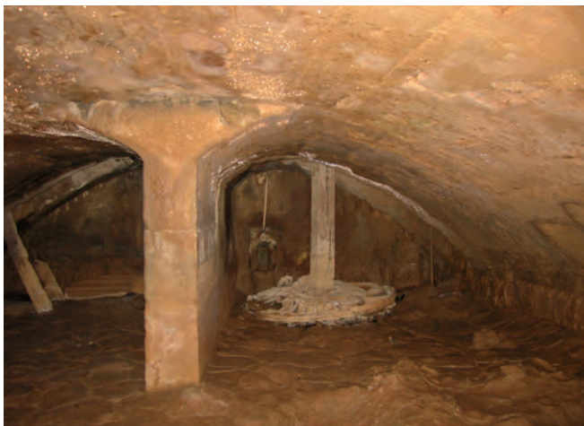
Carcau del molí de Fornells dividit en dos espais. Històricament tant sols hi va haver un sol rodet. L'altre carcau va acollir, ja en ple segle xx, un rodet connectat a una turbina per fer llum.
