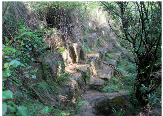
Resclosa feta amb grans blocs de pedra de forma escalonada que recollia les aigües de la riera de Sanauja i mitjançant un canal les portava fins al molí fariner dels Bellons.
