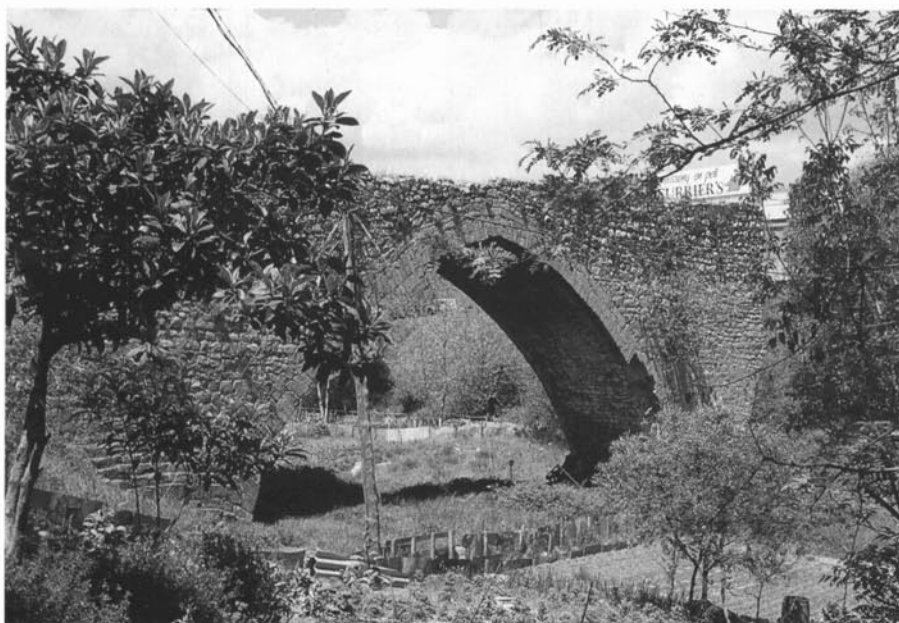
Vista general del pont Trencat. (Fotografia: Cinta Cantarell, 1999)
