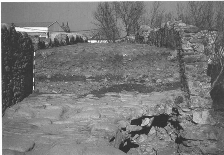
Interior de la caixa de l'estrep sud, secció transversal. (Fotografia: Estrat, 1999)
