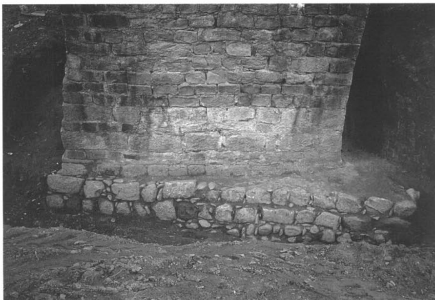
Intradós de l'arc apuntat, banqueta de fonamentació. (Fotografia: Estrat, 1999)
