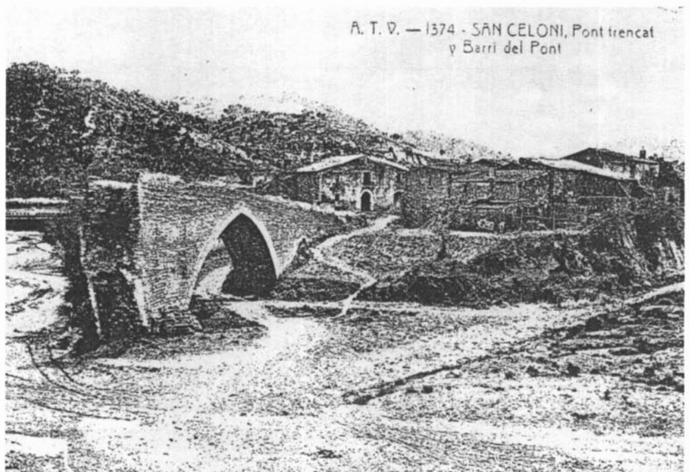
Pont Trencat i barri del Pont, en una fotografia de principi del segle. (Fotografia: HMG, núm. reg. 8.140)
