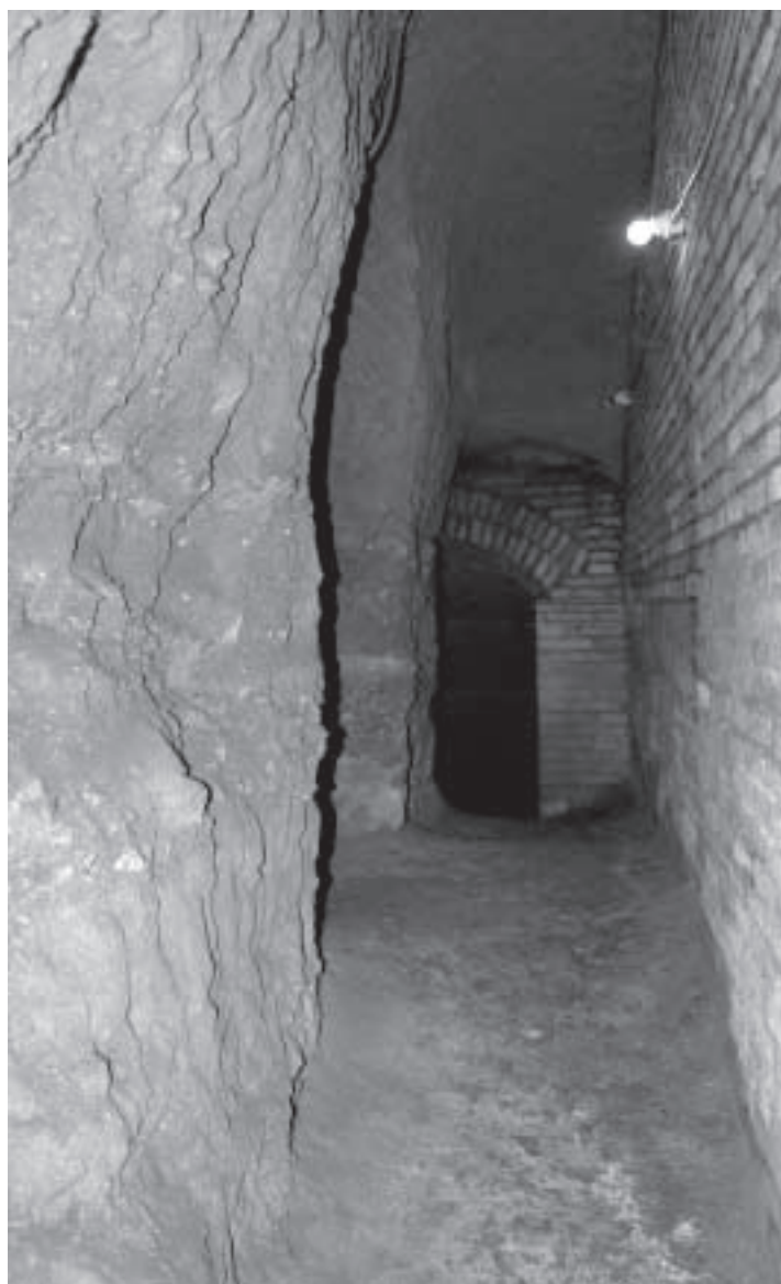
Passadís del número 10, amb el mur de reforç afegit posteriorment.
