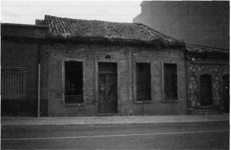
Façana de l'antiga escola, actualment. Fotografia de l'autor.
