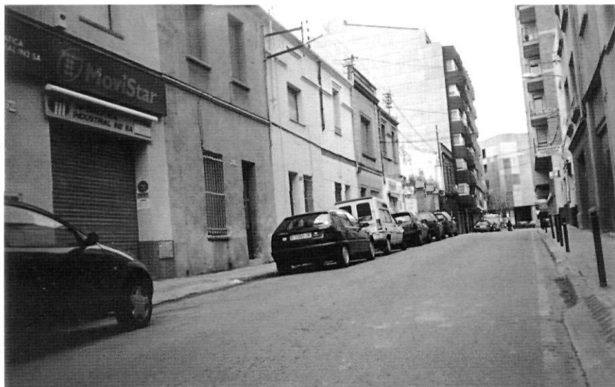
Habitatges construïts per Fomento de la Propiedad, SA, a Terrassa, en el seu estat actual. Fotografia de l'autora.
