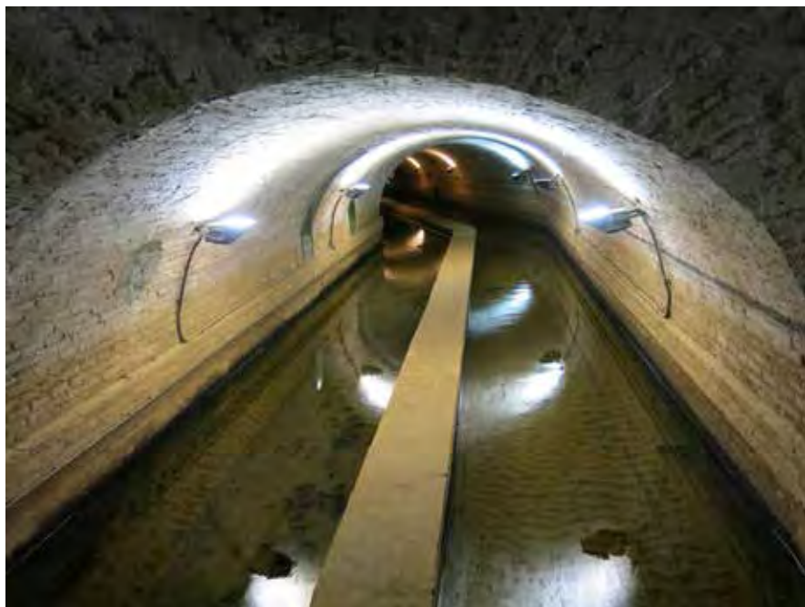
Interior de la mina. Foto: Miquel Jaumot
