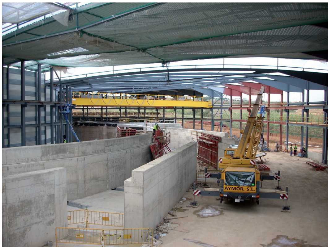
FIGURA 5. Vista de les obres del sincrotró Alba l'octubre de 2007. Es poden veure les parets protectores de formigó entre les quals passarà l'anell, amb les sortides tangencials, una per a cada línia de llum.
