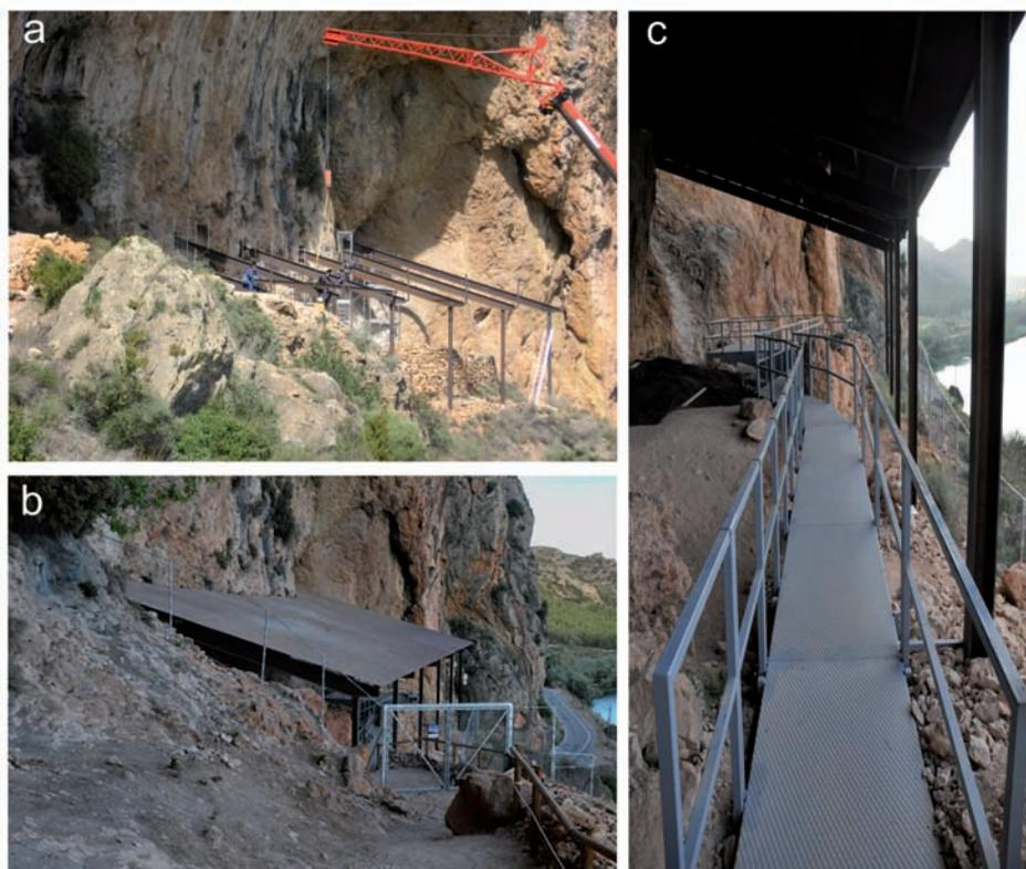
**Figura 3.** Adecuación y protección del yacimiento para el acceso público: a) obras de instalación de cobertura; b) aspecto del yacimiento tras la instalación de las infraestructuras de protección, y c) detalle de las pasarelas que facilitan la circulación del público a lo largo de la visita.
