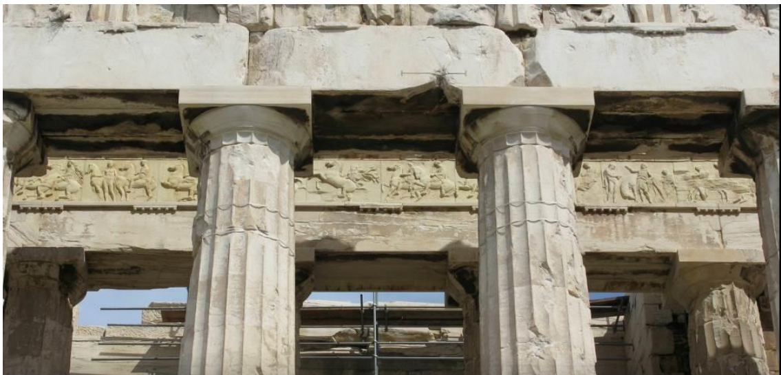
Figura 12 - Detalhes dos frisos que passavam pelos quatro lados do prédio dentro da colunata
