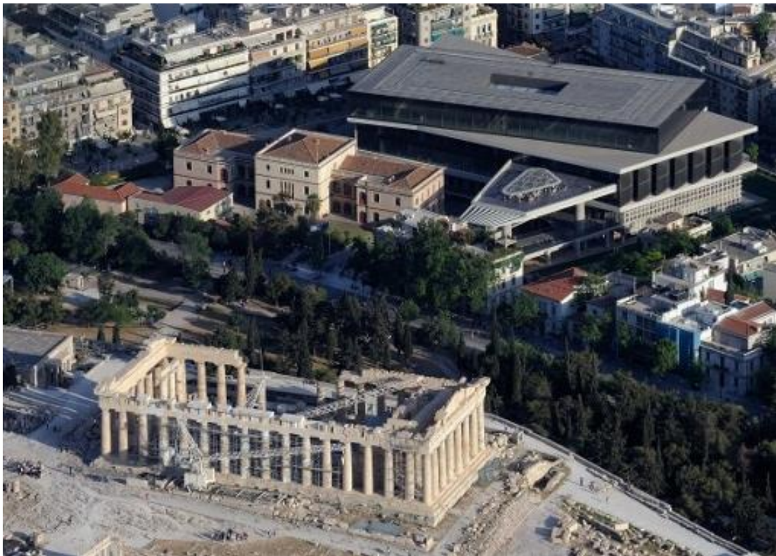
Figura 18 - Vista aérea do Parthenon e do novo Museu da Acrópole
