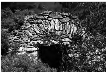
□ Façana bosc. Façana principal amb portell amb llinda de llosa reforçada amb arc de descàrrega.
