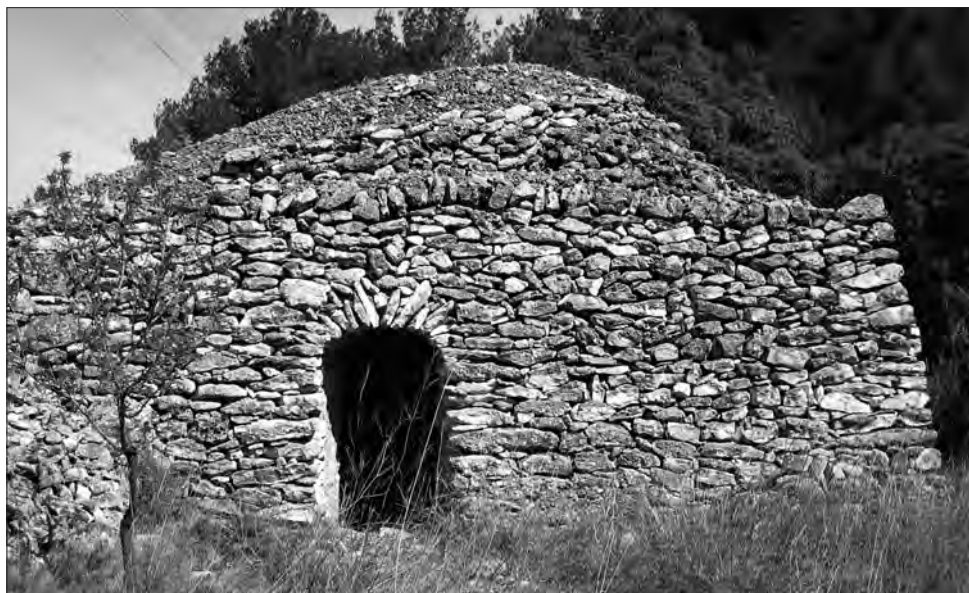
□ Barraca 2 polígon 3. Façana frontal de la barraca.
