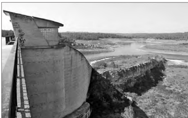
□ Figura 4: Presa del Catllar.
