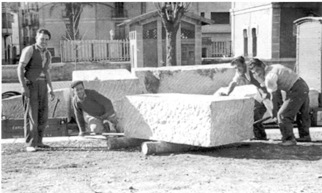
Transportant pedra per l'Estació sobre corrns. Miquel Forcadell Reverté, Teodoro Ribas Patón, Silvio Valls Amorós i Enrique Queralt Sancho. Fotografia cedida per Miquel Forcadell Reverté. Any 1955.
