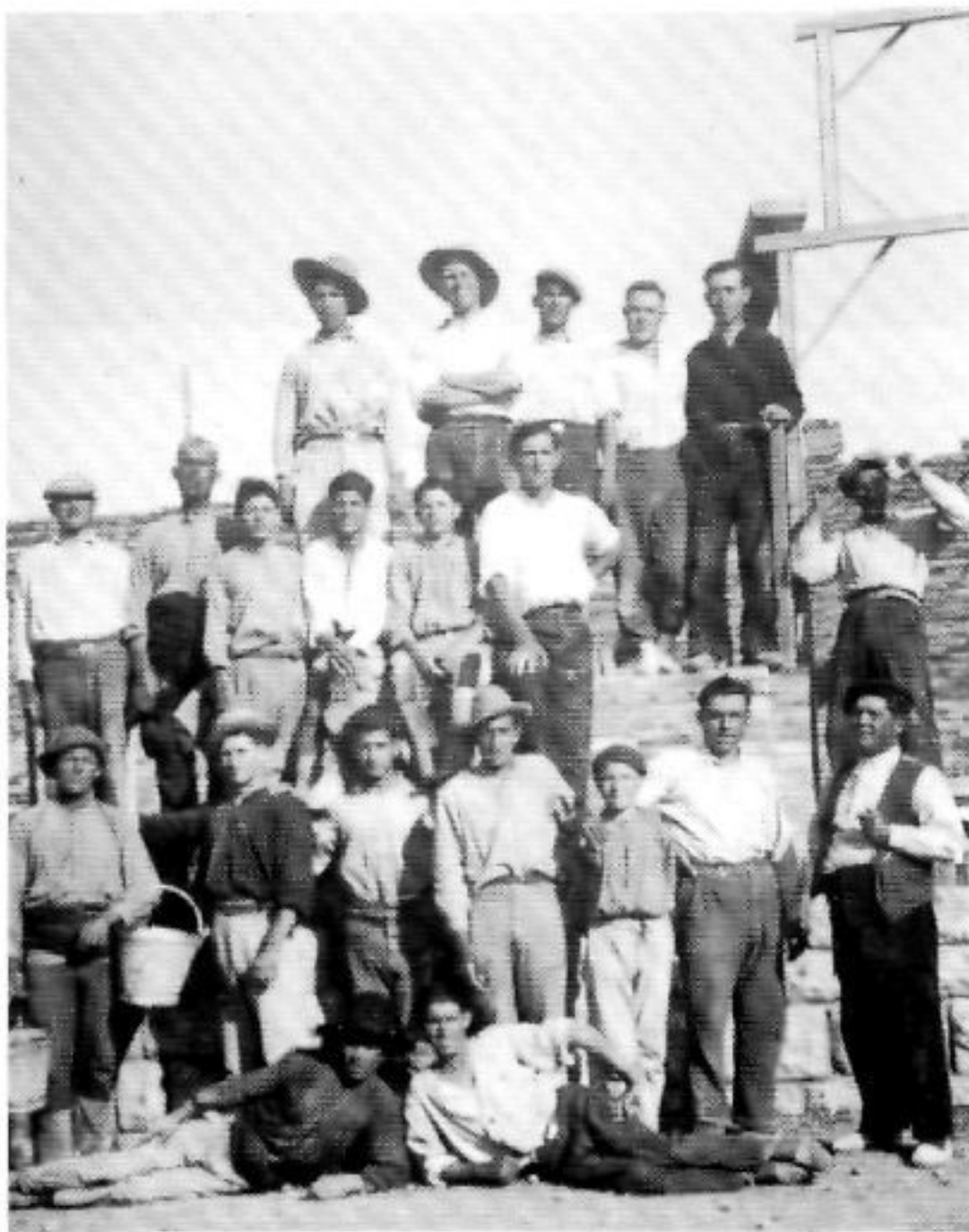
Fotos de la construcció de l'edifici de les escoles. Fotos cedides per Joan Domingo Fonollosa
