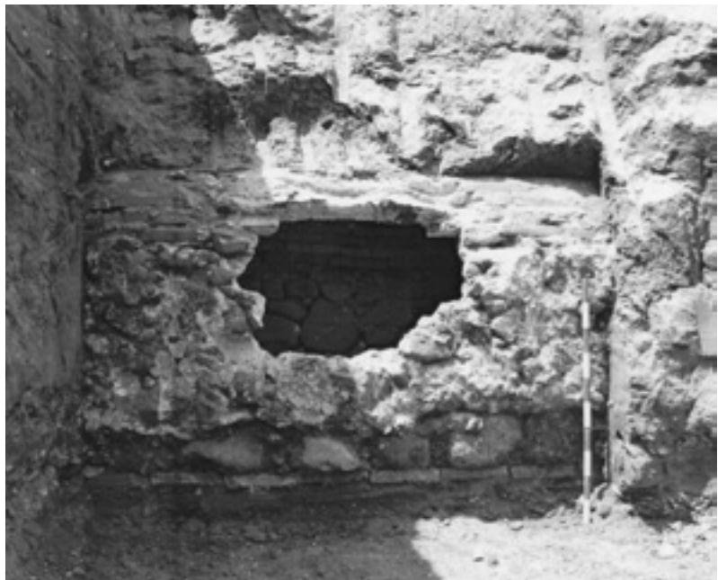
Fig. 7. Secció de la mina d'aigua trobada a Can Bernades - Sobirà amb el forat que li va fer l'excavadora. Font: CENTRE DE RECERQUES I ESTUDIS MOGODA. El patrimoni arqueològic de Santa Perpètua de Mogoda. (L'Ordit 2, anuari del CREM 2008)
