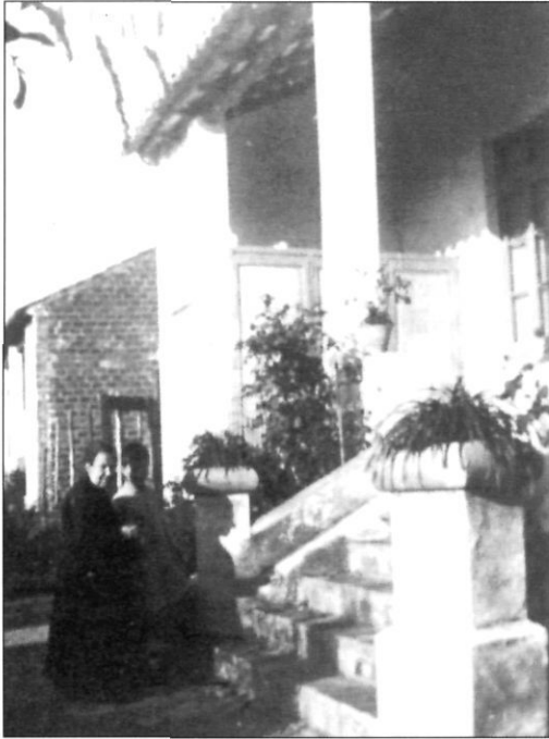
Galeria de l'escola de Nenes en una imatge de finals dels anys 20, on s'observen l'escala i els testos columnats avui desapareguts (Arxiu Puigvert).
