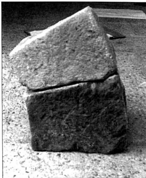
Fig. 6. Dovelles d'arc procedents de la galeria nord del claustre.
