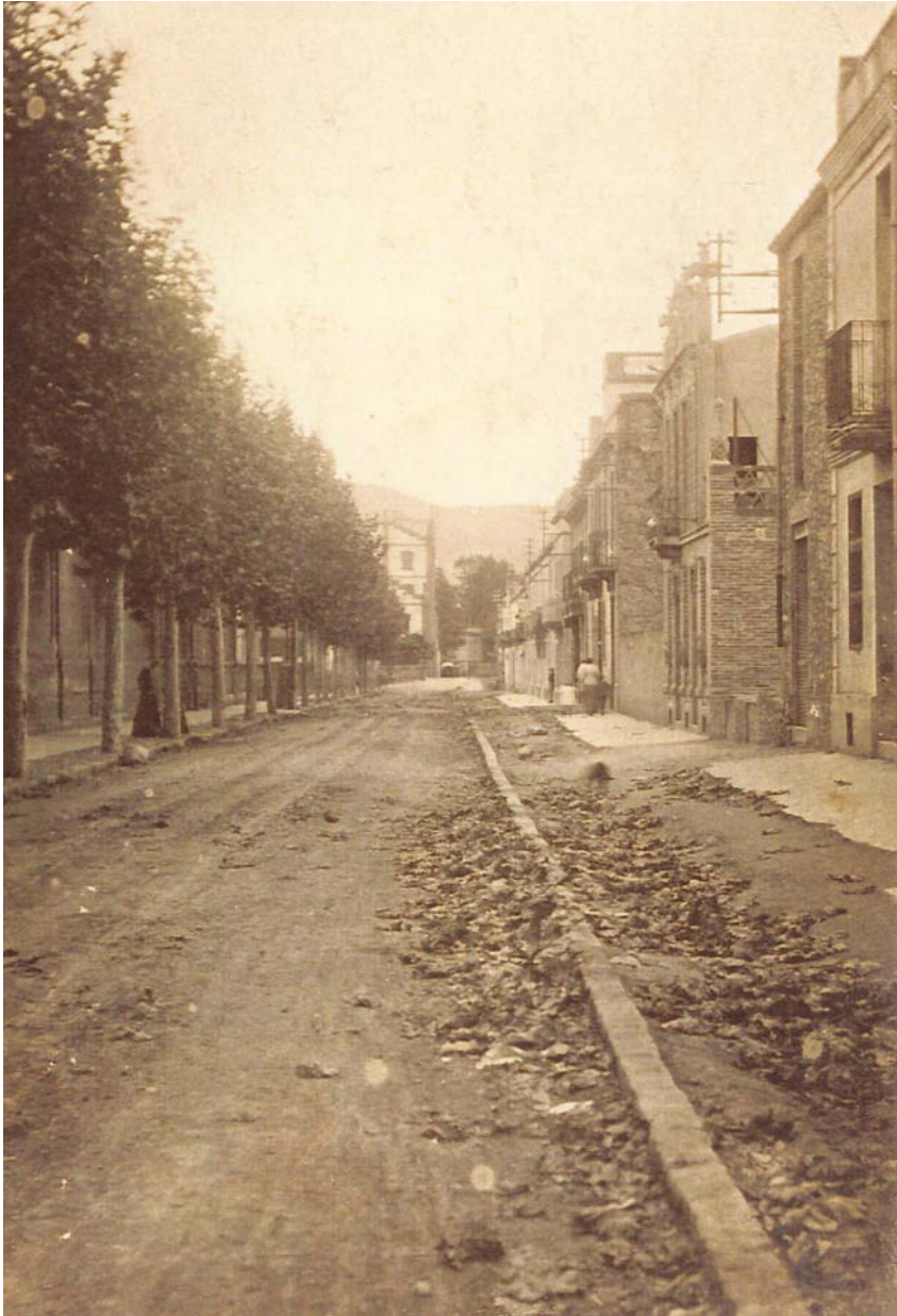
El carrer Berenguer va ser bombardejat el 25 de gener de 1939. Una bomba va caure sobre la teulada de la casa d'en Joan Bas de cal Guano i la va ensorrar.
