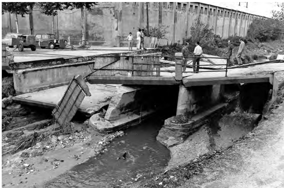
Figura 5. La riuada del 20 de setembre de 1971 va enfonsar el pont sobre el torrent Caganell. Foto: J. Coma
