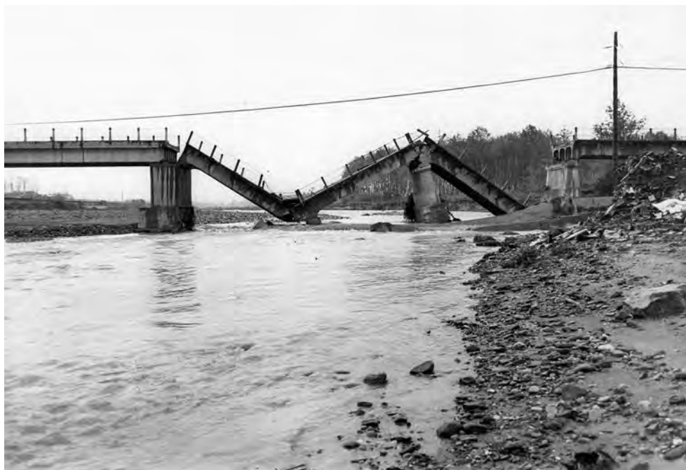
Figura 6. La riuada del 21 de setembre de 1971 va trencar la cinquena pilastra del pont del Besòs a la banda de Martorelles i va provocar la caiguda de dos dels seus trams, fet que el va deixar definitivament inutilitzat. Foto: Arxiu Històric Municipal de Mollet del Vallès
