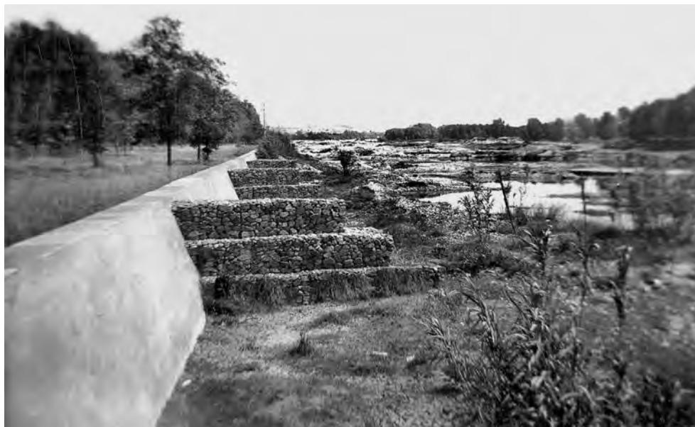
Figura 1. Les contínues crescudes del riu Besòs van obligar a construir murs de contenció per protegir Mollet de les inundacions. Dècada de 1960. Foto: L. Bonal
