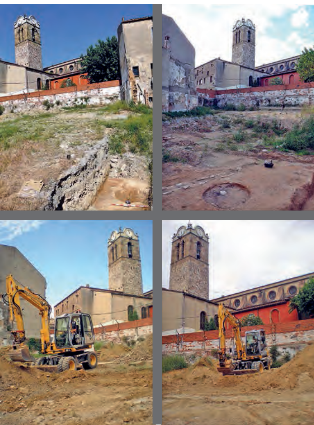
Figura 3. Vistes del solar del c/Gaietà Ventalló, 15-23 just a l'inici dels treballs arqueològics de prospecció i retirada de terres superficials. S'observa la proximitat amb l'edifici de l'església, així com el desnivell existent respecte al c/Sant Oleguer Foto: J. Roig-Arrago, 2008
