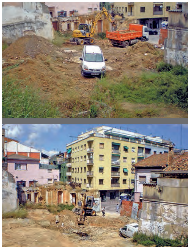
Figura 4. Vista dels treballs de prospecció arqueològica i retirada de terres superficials de l'any 2008 en el solar del c/Gaietà Ventalló, 15-23 Foto: J. Roig-Arrago, 2008
