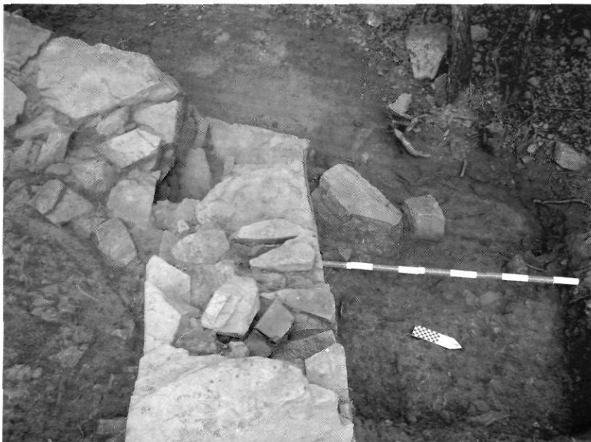
Fig. 4: Imatge del desviament de 140 ° de la cantonada nord del mur perimetral.
