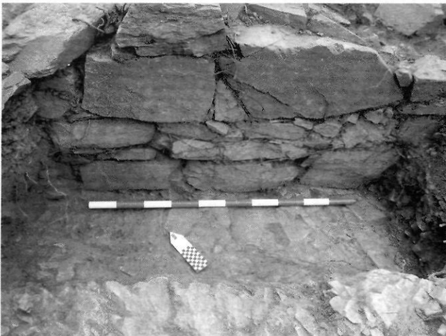
Fig. 17: Detall de la rasa de fonamentació de la muralla sud.
