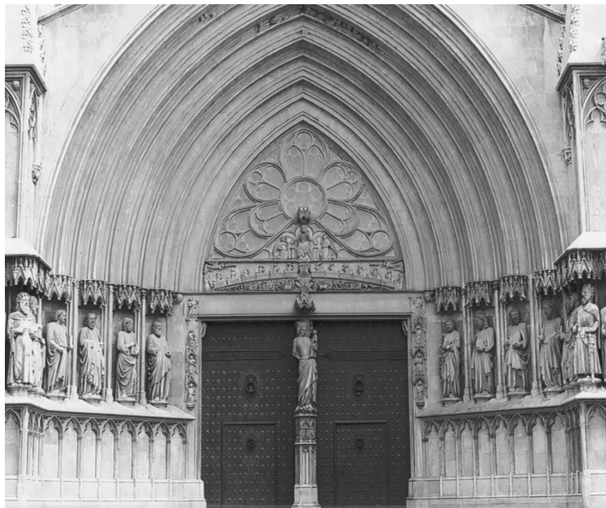
Figura 8. Façana de la catedral de Tarragona. General.
