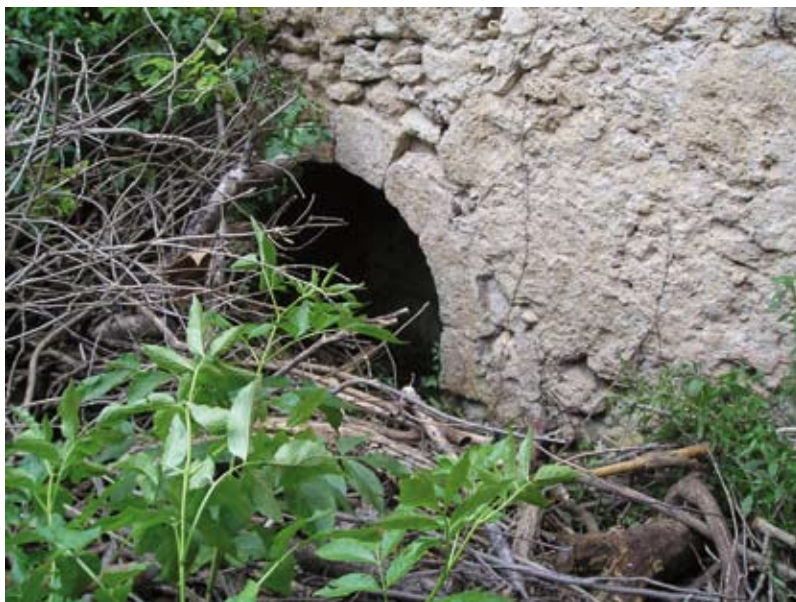
Fig.11, Forat de suport de l’eix de la roda hidràulica de la Fàbrica del Ferro
