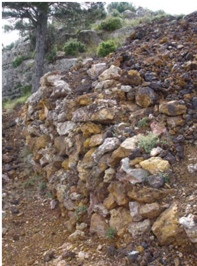
Fig. 4, Marge de pedra seca al costat de les mines
