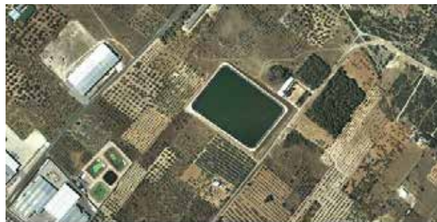
Vista aèria de la bassa d'acumulació i regulació de la Comunitat de Regants de la Depuradora. Font: Institut Cartogràfic de Catalunya (ICC)
