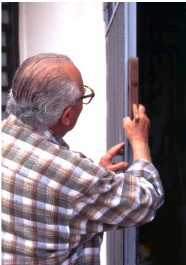
Mostrant com se rebaixa el canto d'una porta utilitzant el guillaume. Fons CES
