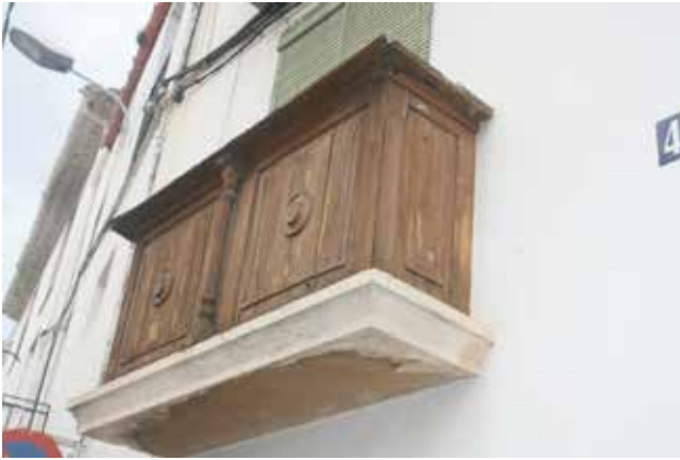
Detall del balcó de la casa Prades. L'obra de fusta és de Joan Querol. Font: Centre d'Estudis Seniencs
