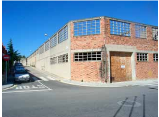
Façana del darrere de la fàbrica de Muebles Gascó y Jornet. Foto: Ma. Mar Villabí.
