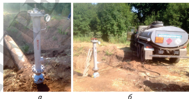
Рис. 2. Пристрій для видалення рідини з внутрішньої порожнини трубопроводу (а) та процес дренажу рідини в автоцистерну (б)
