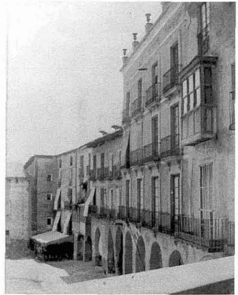
Perspectiva de la Casa Thomasa presa des de la balconada de la casa dels Puig-Olzina amb el conjunt d'habitatges que tanquen la Fira pel seu extrem occidental, ca. 1900 (Arxiu Històric de Cardona).
