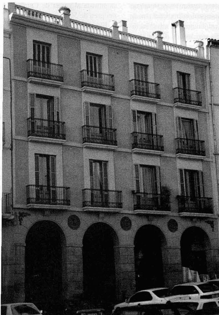
La casa Thomasa, després de la restauració endegada al 1995 (J. Porredon, 2002)
