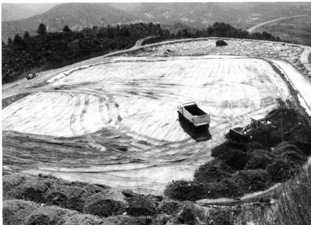
L'antic Abocador Comarcal del Bages en procés de colmatació i clausura. (Foto: Mancomunitat de Municipis del Bages per l'Abocador).
