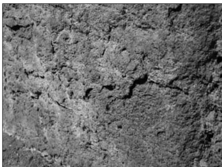
Detalls dels carreus dels murs a la zona interior de la cel·la. S'aprecia l'exfoliació i la descamació de la pedra.
