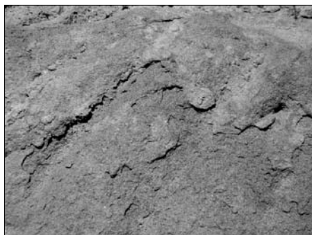
Detalls dels carreus dels murs a la zona interior de la cel·la. S'aprecia l'exfoliació i la descamació de la pedra.
