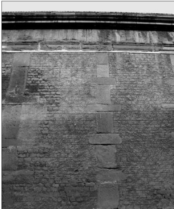
Paret del migdia (sud). S'observa clarament la línia que indica la incidència del sol sobre el mur.
