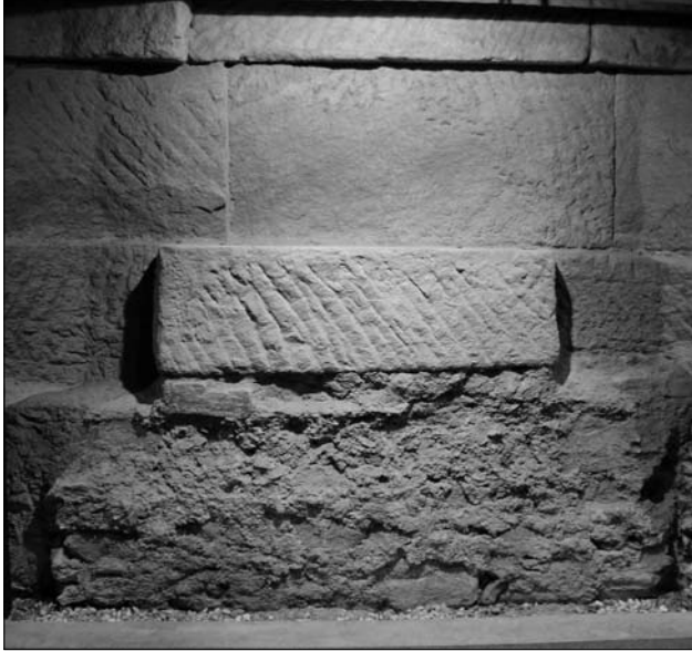
Detall d'un dels murs a la zona interior de la cel·la. Es poden apreciar els fonaments, realitzats amb maçoneria, i sobre aquests el podi, format de tres fileres de grans carreus de pedra sorrenca.
