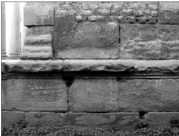
Detall de la paret de tramuntana. Apareix part del podi amb la cornisa, sobre el qual s'aixeca el mur.
