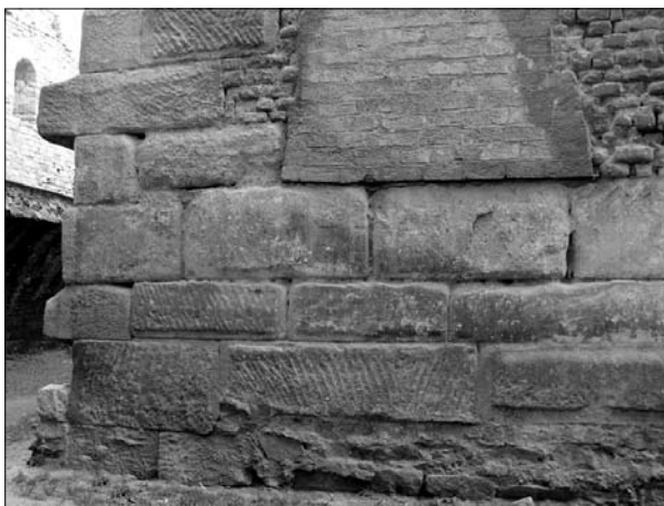
Detall de la paret de ponent. Apareixen part dels fonaments, sobre els quals s'aixeca el mur.
