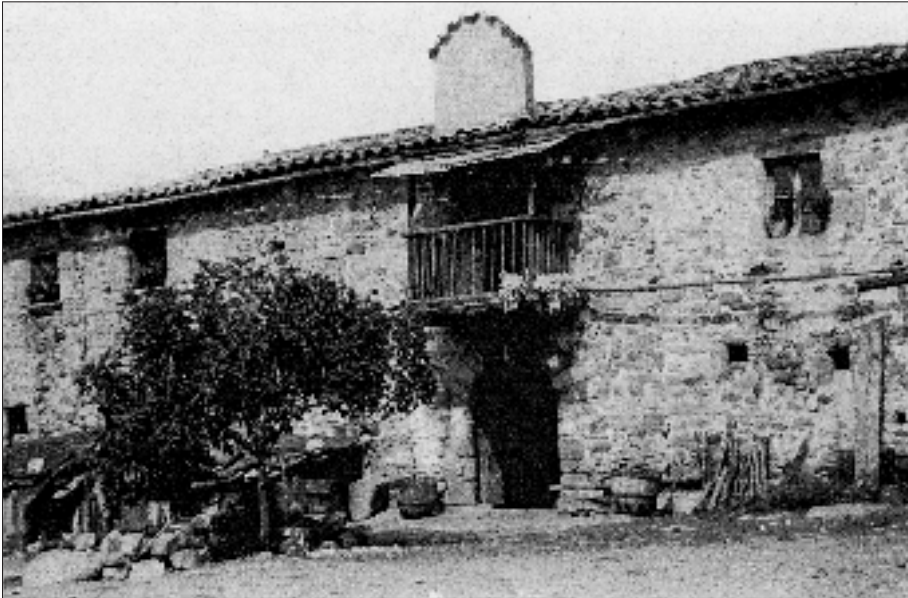
La casa de Serrallonga de Querós –en la fotografia de Salvador Bosch als voltants de 1960– va ser refugi del mític bandoler.
